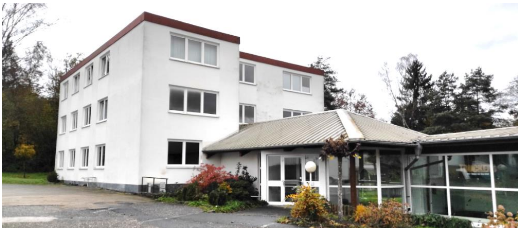
Abb. 7: vorhandenes, leerstehende Bürogebäude
