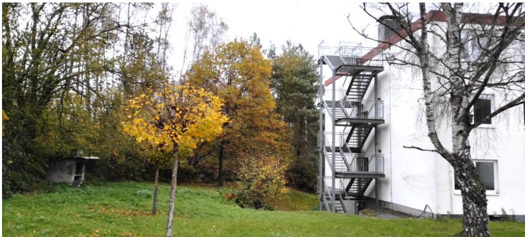
Abb. 8: Übergang vom Bürogebäude zum Gehölzbestand
