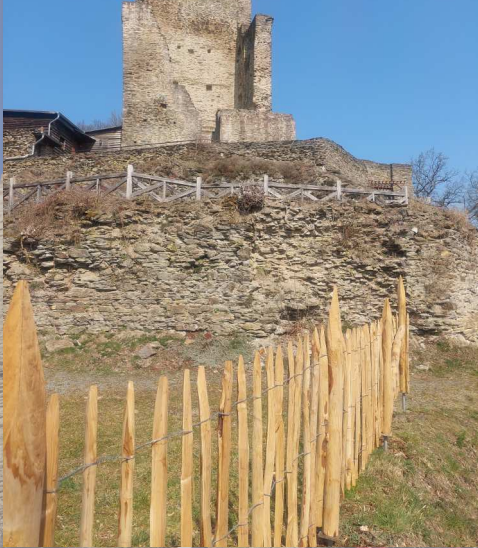
Austausch morsche Zaunanlage
